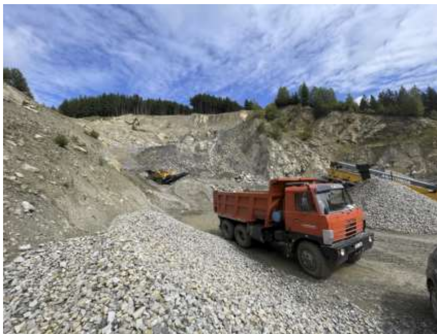
Obr. 52: Lom Ratiboř u Vsetína celkový pohled na roztěžený lom (Godany a kol. 2024).
